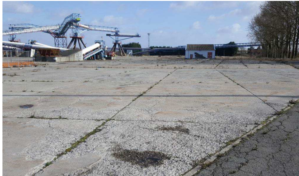
Figure 49 : Photo 2 : Vue du site depuis le sud du site et orientée vers l'Est (source : Goodman, 2017)
